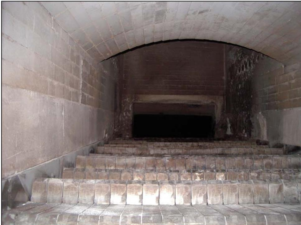
**Figura 5.3: Focolare caldaia a biomassa a ciclo Rankine a vapore (Caldia Mawera)**
