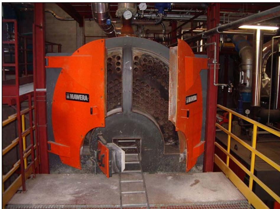
**Figura 5.2: Caldaia a biomassa a ciclo Rankine a vapore (Caldaia Mawera)**
