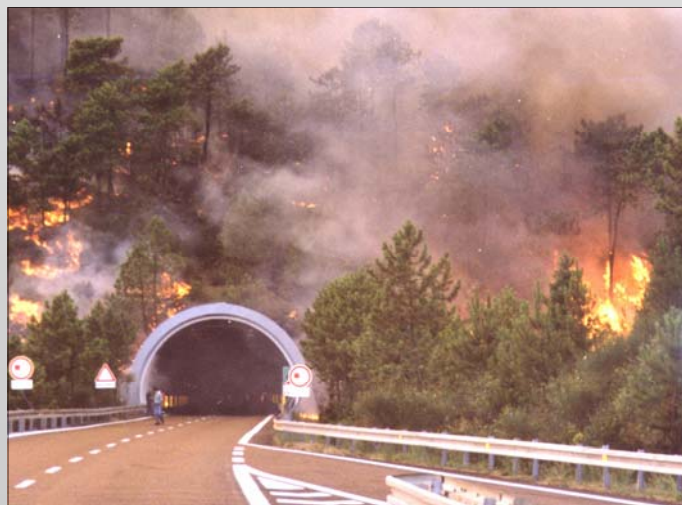
Incendio di bosco di Pino marittimo. Comune di Deiva Marina (SP), agosto 1998. Con fronti del fuoco di queste proporzioni bisogna ricorrere necessariamente ad un attacco di tipo indiretto
